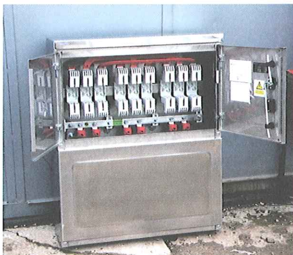
Obr. 16.14 Káblová rozpojovacia a istiacia skriňa PRIS 2
