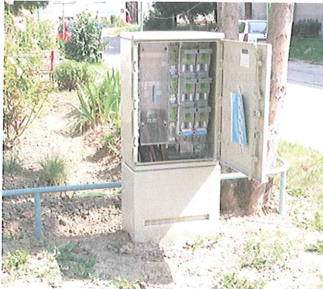
Obr. 16.11 Pozemná rozvodná káblová skriňa voľne stojaca
