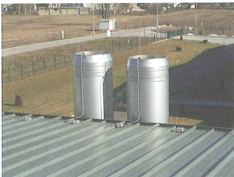
Obr.11.4.5 Prepojovací pružný pás umožňuje vyrovnanie dilatčných zmien pri dlhých vedeniach
