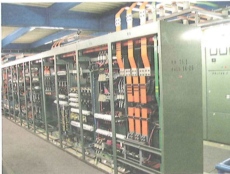
Obr. 16.2 Panelový rozvádzač
