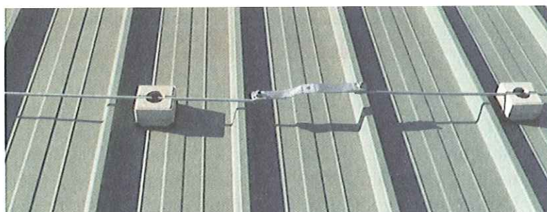
Obr.11.4.5 Prepojovací pružný pás umožňuje vyrovnanie dilatčných zmien pri dlhých vedeniach
