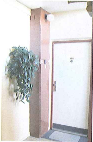
Obr. 16.3 Krytý rozvádzač
