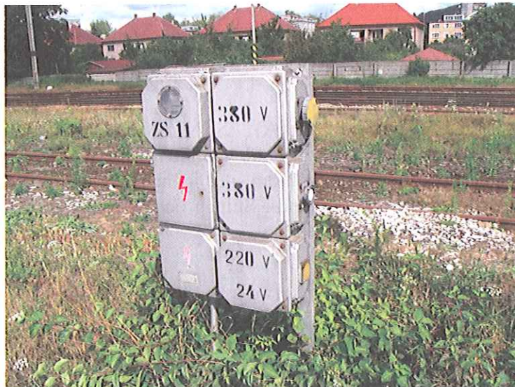
Obr. 15.9 Stavebnicová zostava rozvodníc
