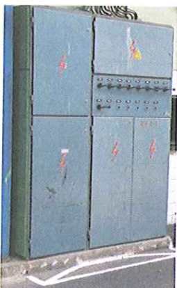
Obr. 16.5 Skriňový stavebnicový rozvádzač
