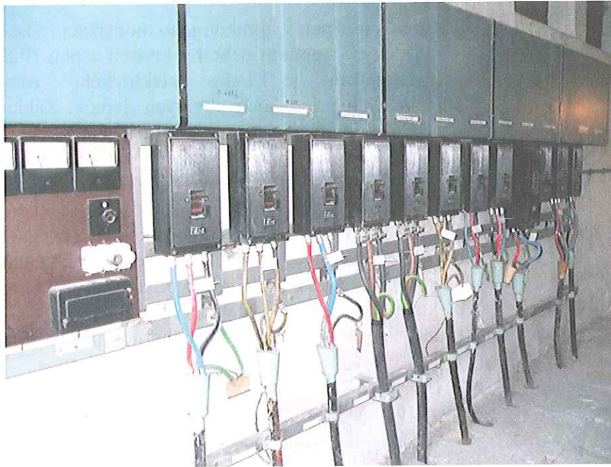
Obr. 16.1 Nekrytý (rámový) rozvádzač
