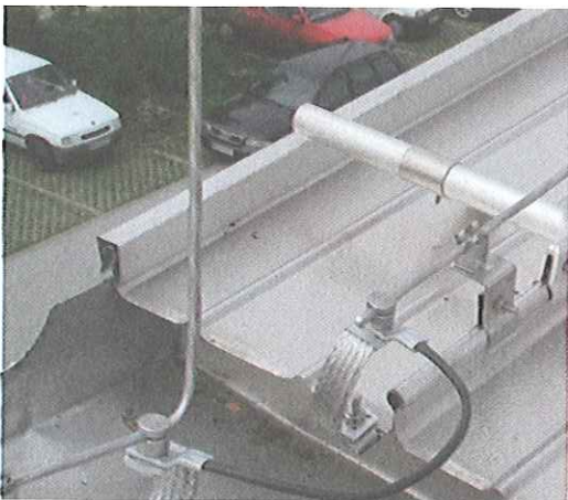
Obr.11.2.5b Neizolovaný bleskozvod na streche s vodivou krytinou a zachytávacou sústavou
