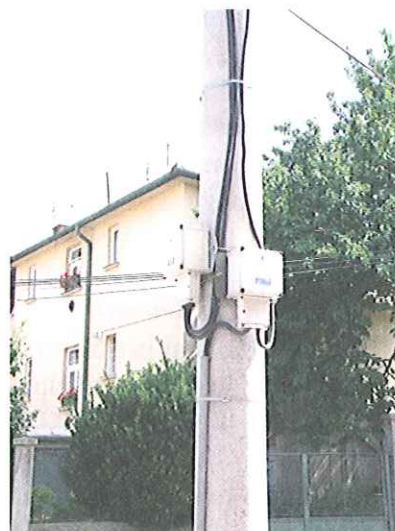
Obr. 16.13 Stožiarová prípojková skriňa IPS
