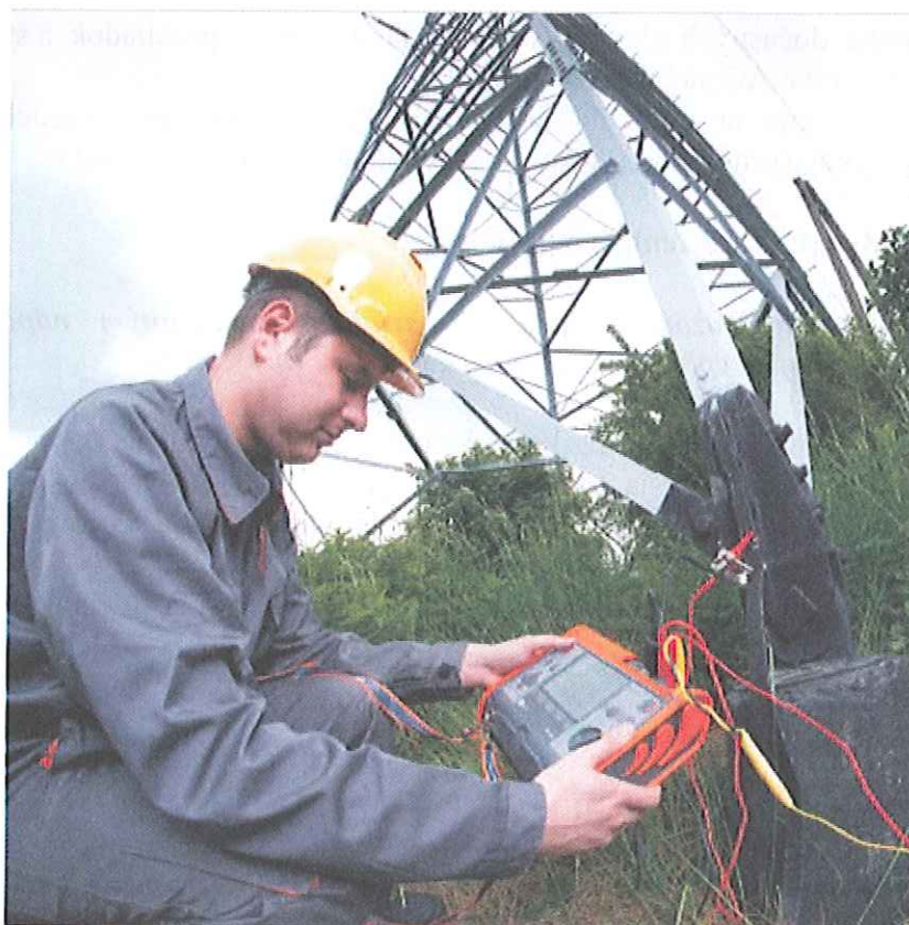
Obr.23.10 Meranie odporu uzemnenia na stožiarí VN
