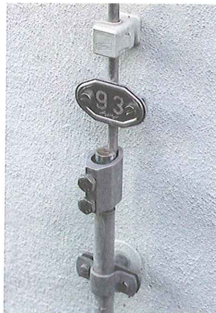
Obr.11.2.16 skúšobná svorka na zvide
