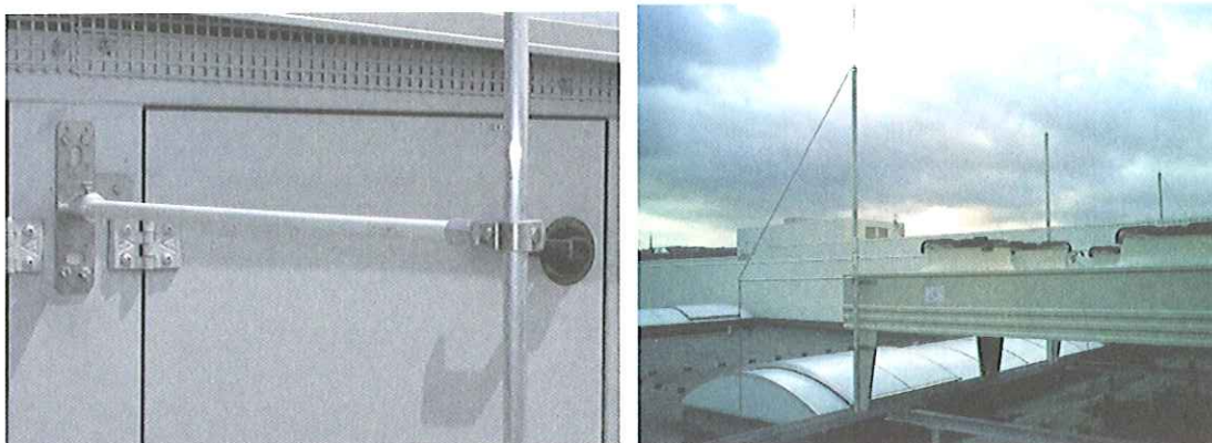
Obr. 11.2.4a Izolačná tyč použitá na uchytenie zachytávacej tyče pri zhotovovaní izolovaného (oddialeného) bleskozvodu.
