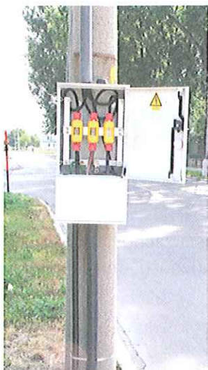
Obr. 16.12 Stožiarová káblová rozvodná skriňa VRIS
